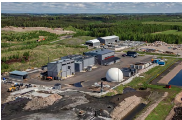
Рисунок 55. Биогазовая установка в центре по обращению с отходами Куккурройнмяки.
